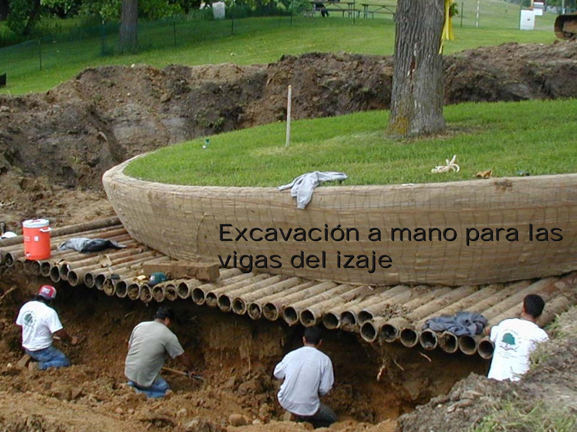
Excavación a mano para las vigas del izaje
